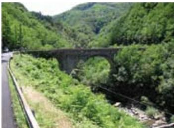
Si considera un Ponte stradale in muratura di pietra composto da tre archi, di cui l'arcata centrale ha luce pari a 21.5 m e quelle laterali di 8 m. Il ponte è lungo complessivamente 72.5 m e largo 5.8 m. La muratura del volto risulta in mattoni e malta ce-
