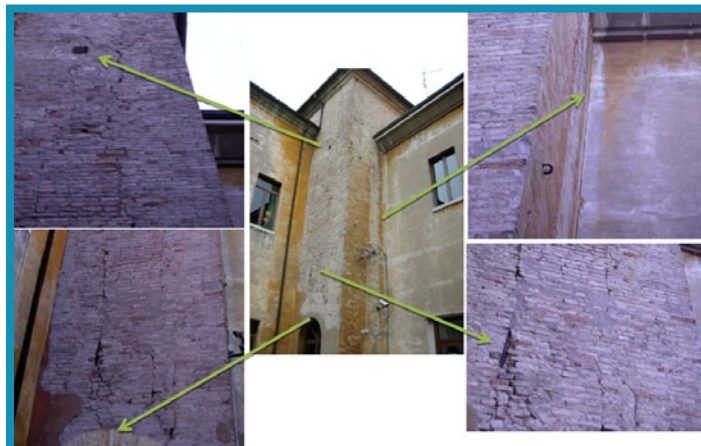
Figura 20: Vista dell'antica torre muraria giuntata con i due corpi di fabbrica più recenti con fessure verticali
